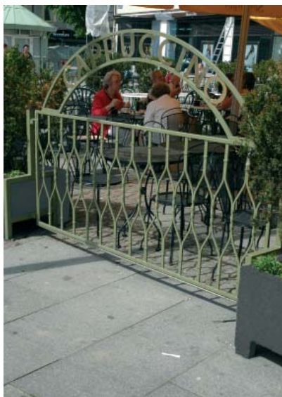
Vackert smidesstaket med stöd i form av blomsterurnor. Staketet bör dock utföras i en enhetlig ytterlinje längs gatan för att underlätta för synsvaga med käpp.
