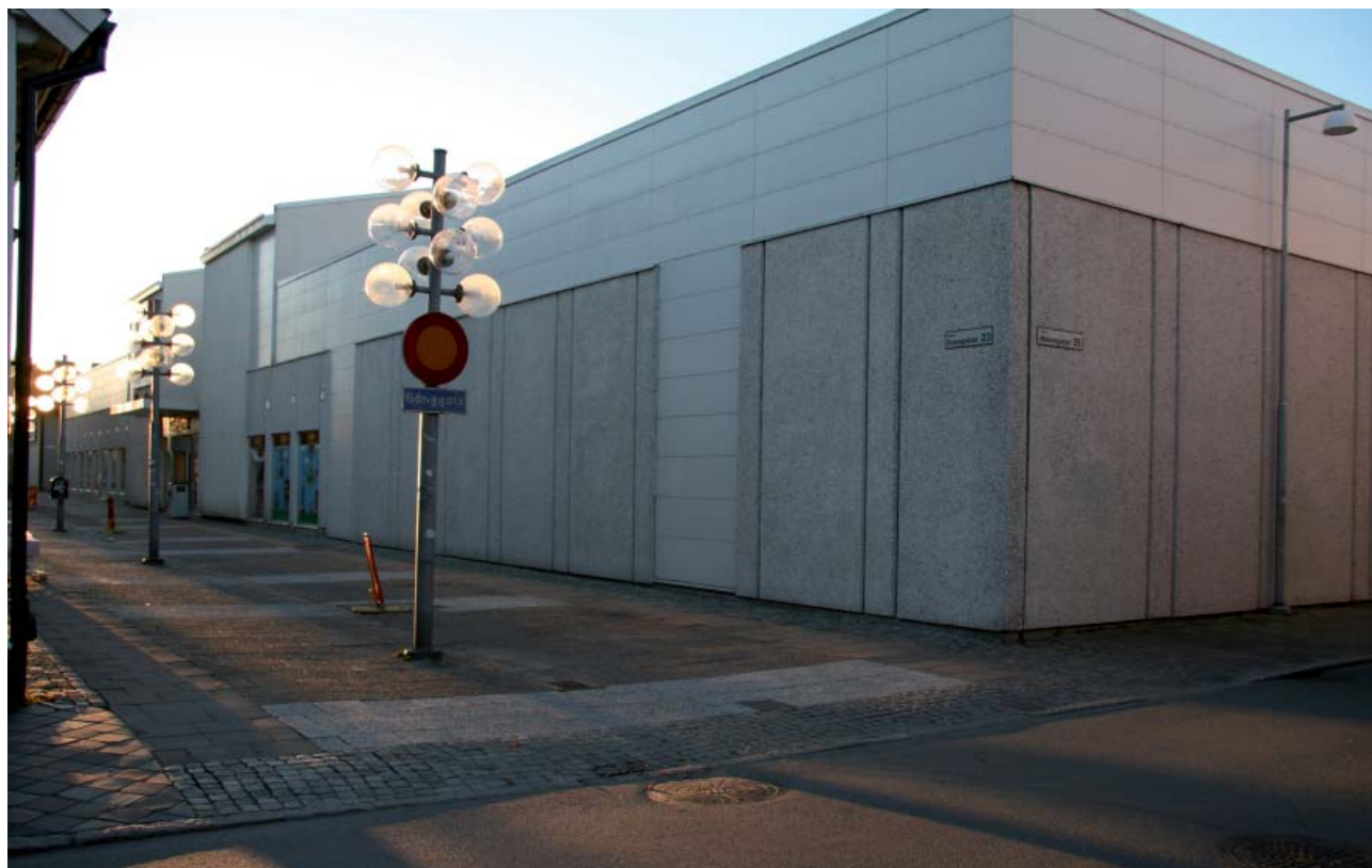
Åhlénsvaruhuset i De la Gardeiestadens rutnätsplan från 1671 i Lidköping är ett exempel på storsklighet och där betongelementen i fasaden har använts som ett arkitektoniskt uttryckssätt. Intrycket är brutalt avvisande. Ett typiskt exempel på 60-tals neobrutalism. Byggnaden är ombyggd sedan 2005 och ger nu ett mindre brutalt intryck.
