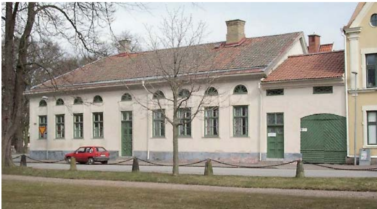
Enkelt nyklassicistiskt bostadshus vid Norra Kyrkogatan, byggt vid mitten av 1800 talet . Notera enkelheten i fasaduttrycket.
