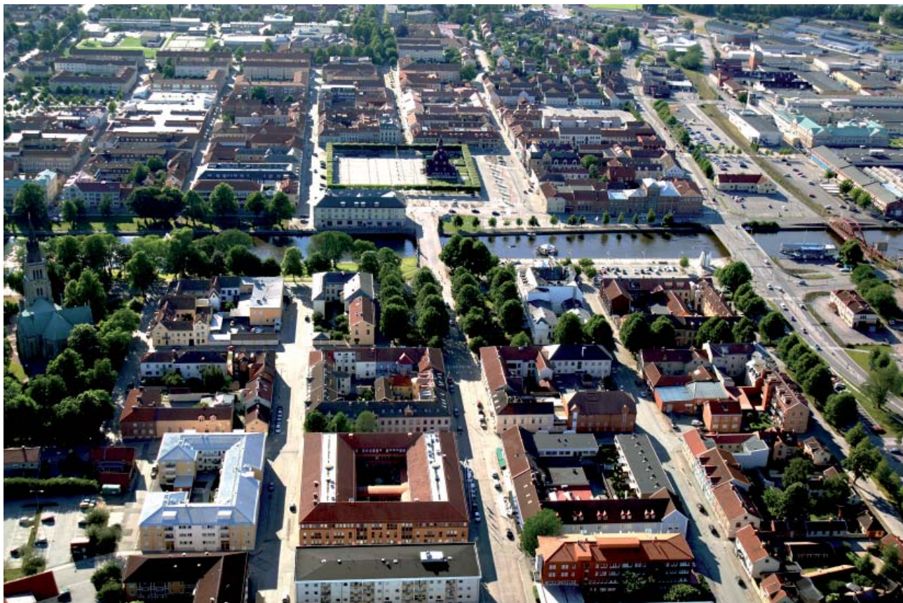
Vy från öster, Skaragatan över Gamla Stadens torg över Nya Stadens torg och mot Stenportsgatan
