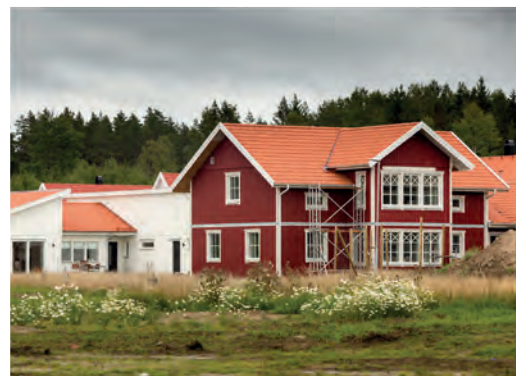
Det mesta byggandet sker i staden
